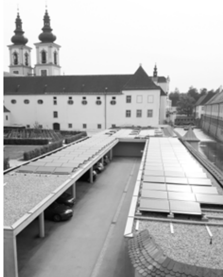
Blick vom Konferenzzimmer auf die Carports mit den montierten Elementen der PV-Anlage
