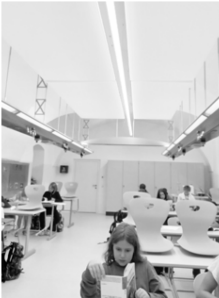
Im Chemiesaal: Schalldämmungselemente neben der Mittelbeleuchtung
